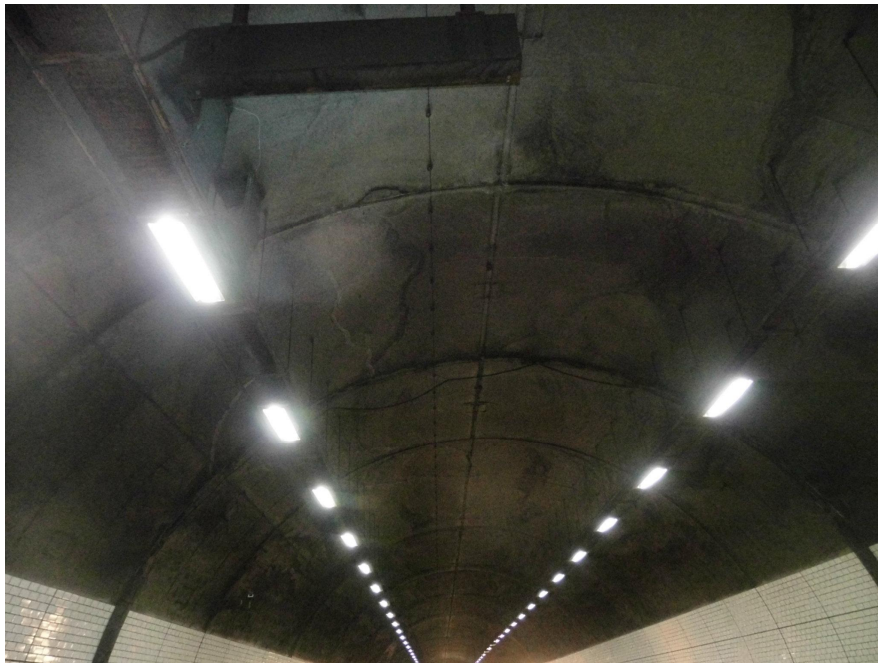
터널 천단부 전경
