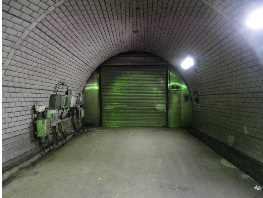
피난 연락갱 전경
