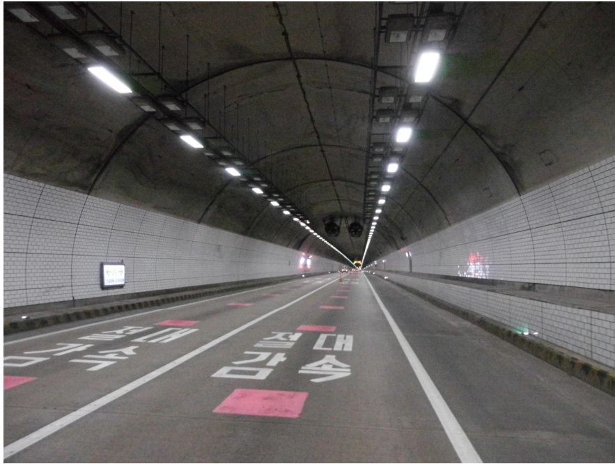
터널 내부 전경
